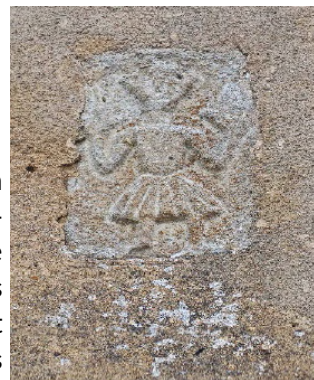
▲ Bas-relief observable en partie supérieure de la façade occidentale
