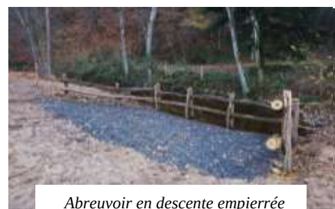
Abreuvoir en descente empierrée installé en octobre 2018
