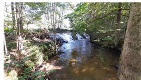
Relevé diagnostic - seuil infranchissable
