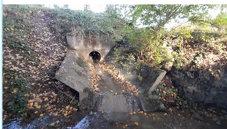
Relevé diagnostic - rejet au cours d'eau
